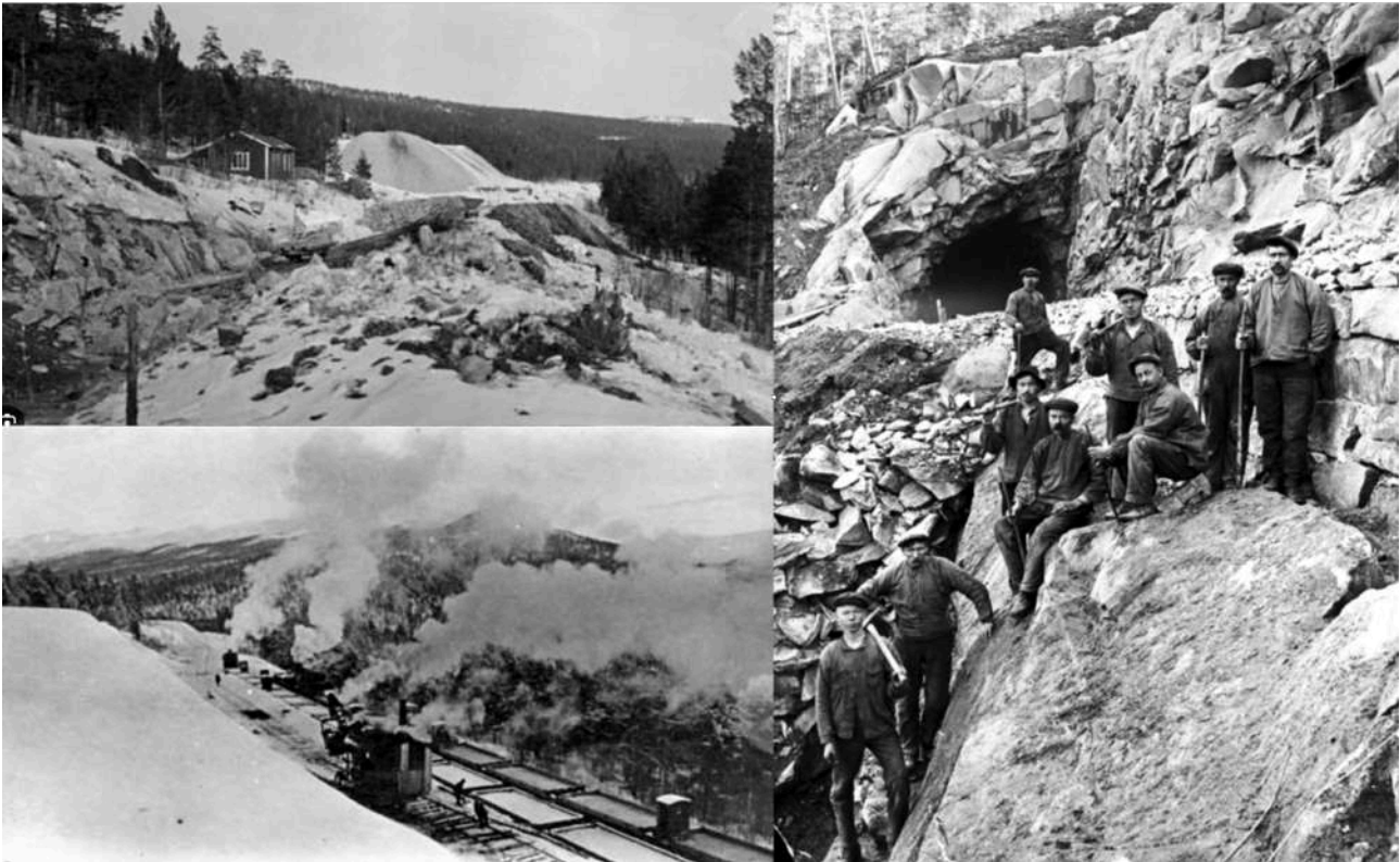
Figur 2. Bilder fra omkring første verdenskrig som viser til venstre tidlig drift i pukkverket og til høyre arbeiderene som bygget tunnelen, bilder fra Norsk jernbane museum
