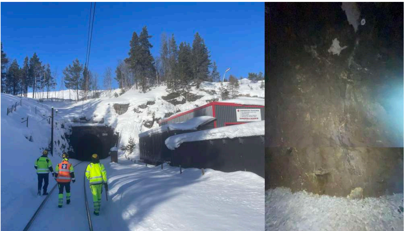
Figur 6. Sett mot den øvre inngangen til vendetunnelen, i bergveggen til høyre kan observeres hvordan lagningen ligger nær horisontalt med et svakt fall mot sørvest; til høyre en av de i teksten omtalte tette sprekkene som går perpendikulært på tunneltraseen
