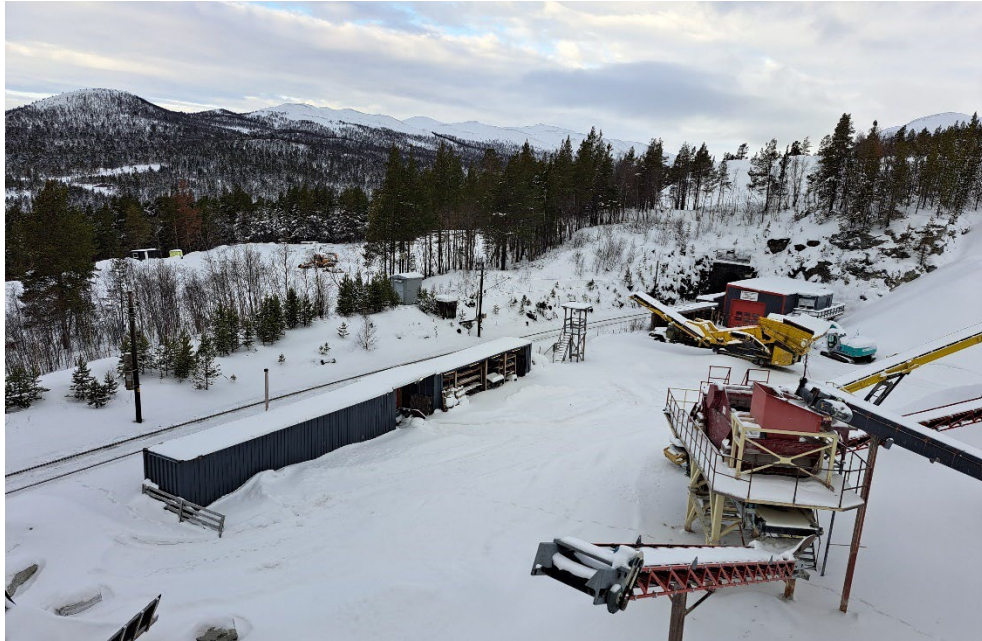
Figur 16: Containerrekke sett opp mellom fjelltaket og øvste jernbaneline.
