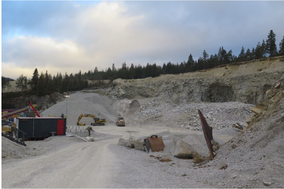
Figur 14: Frå anlegget i fjelltaket. Sett mot nordvest.
