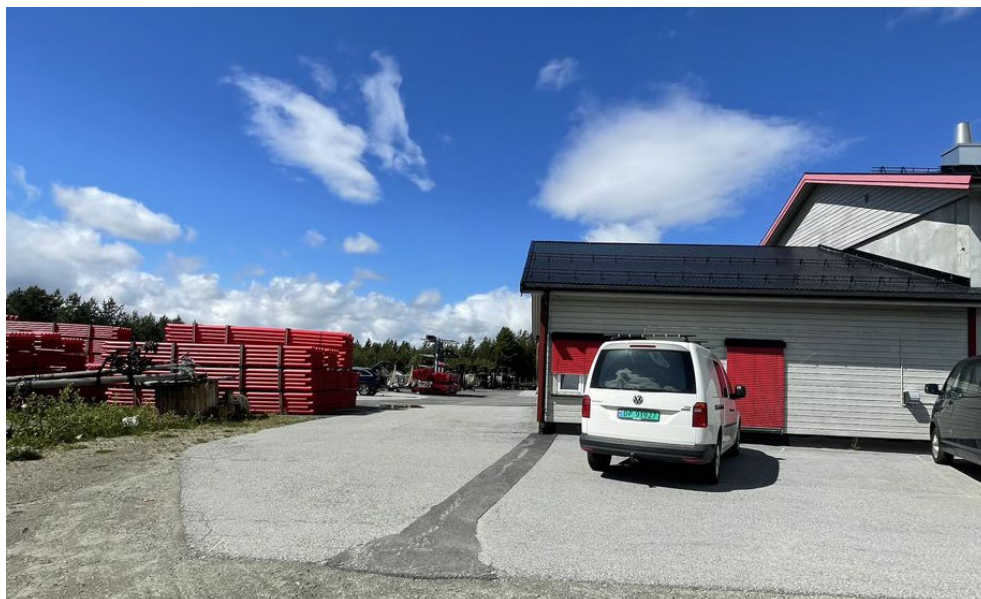
Eksisterende bygning som ynskjes utvida. Sett mot vest.
