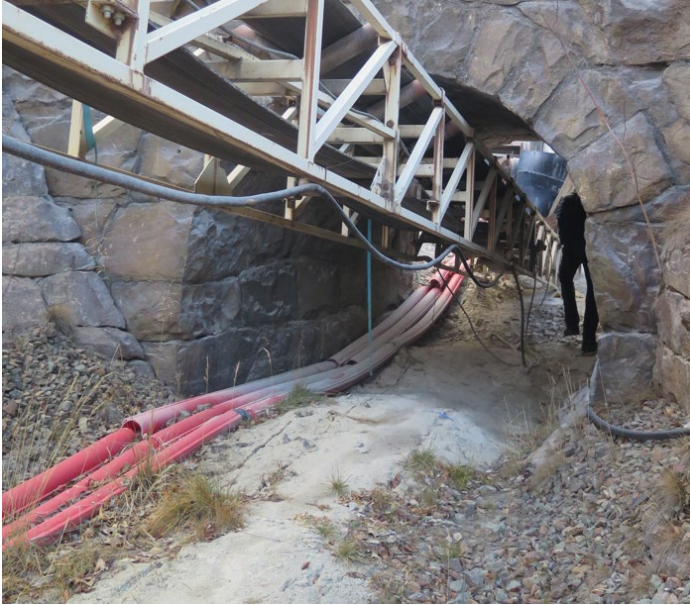
Figur 7 – Bildet av undergang under jernbanen med gummibånd for massetransport
